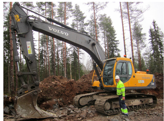
Exempel på byggnation av kabelschakt för elanslutning längs väg.
